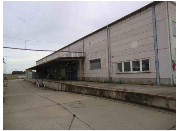
Halle 2 mit Rampen
